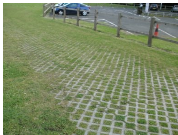
Exemples de revêtements perméables et carrossables
