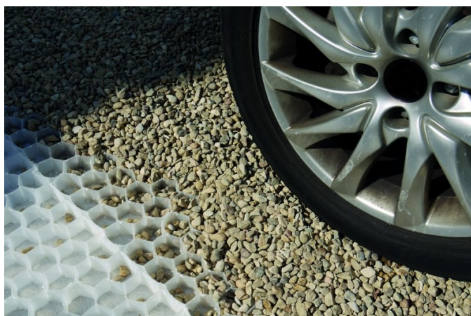
Exemples de revêtements perméables et carrossables
